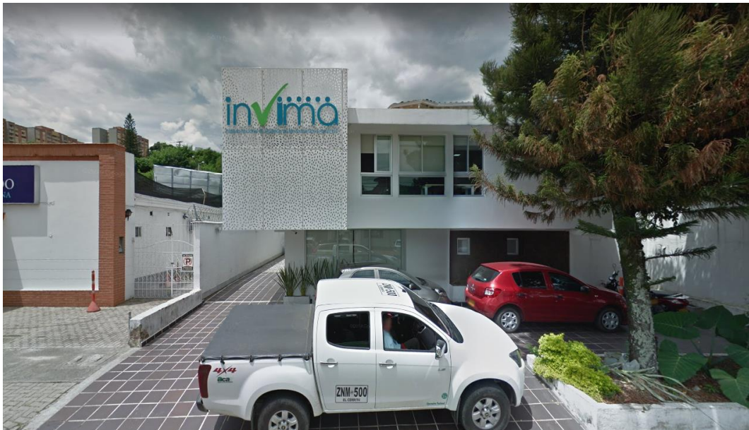
Fotografía De La Fachada
